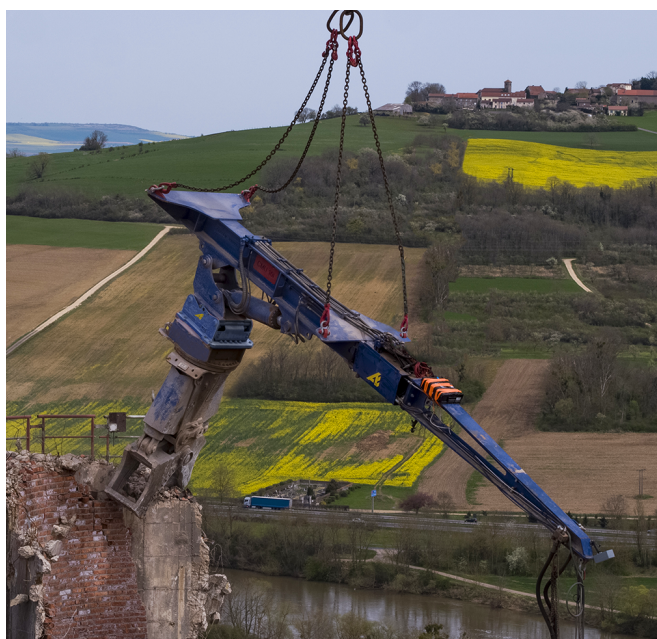
Potence de démolition équipée d'une AIO 601 et d'une CU042
